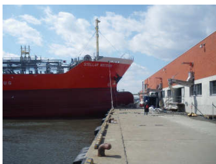
ハサップ対応型荷捌き施設A棟
